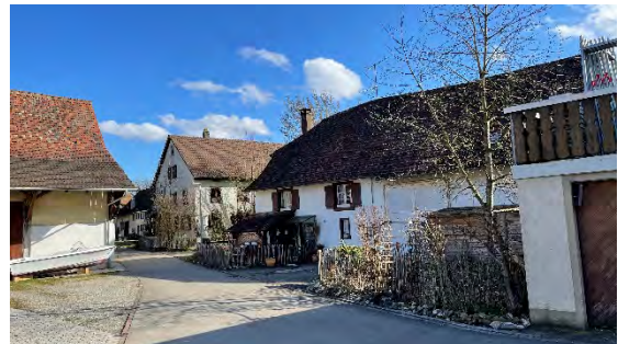
Abb. 17: Alte Bausubstanz im Unterdorf
