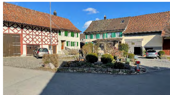
Abb. 51: Vorplätze bzw. attraktiver Strassenraum Underdorf
