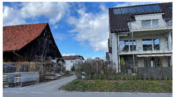
Abb. 10: Heterogene Bebauungsstruktur an der Bahnhofstrasse
