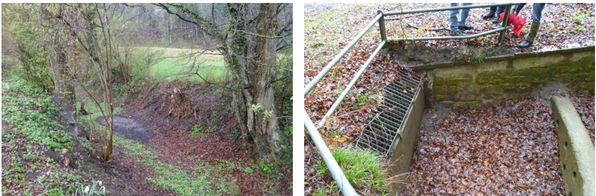
Abbildung 6 Wiesholzgraben, Abschnitt oberhalb QP612 (links) und einer der weiter oberhalb liegenden Geschiebesammler am Waldrand
