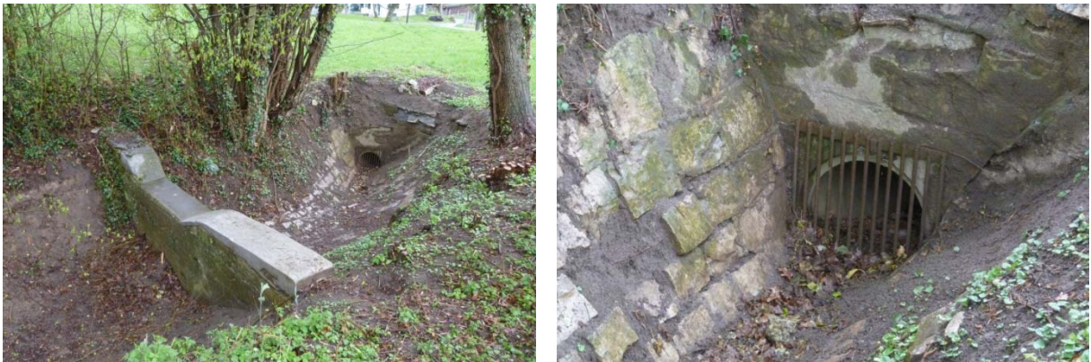
Abbildung 5 Schwachstelle Wiesholzgraben QP612, Eindolung mit vorgelagerter Betonsperre und Rechen
